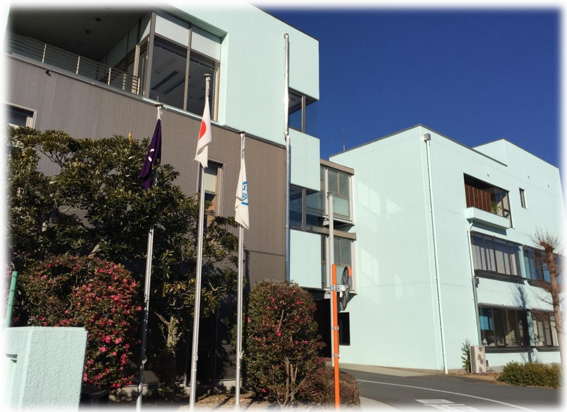
茨城県南水道企業団事務所棟
