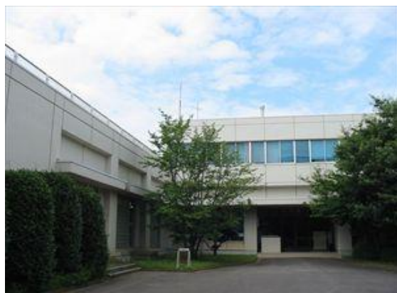
若柴配水場 管理棟
