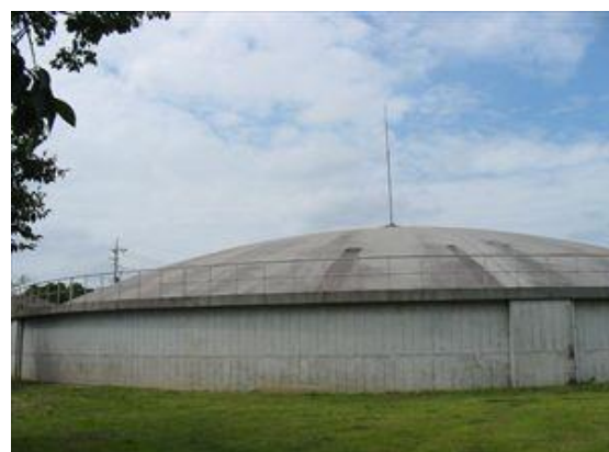
若柴配水場 4号配水池
