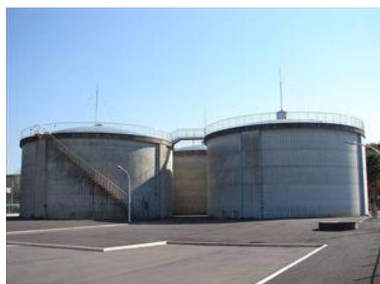
牛久配水場 配水池
