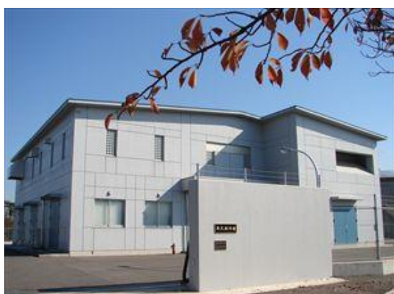
牛久配水場 管理棟
