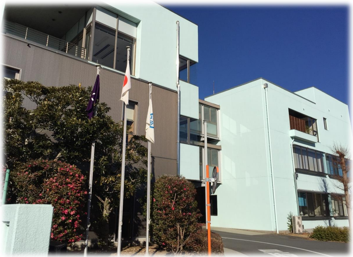
茨城県南水道企業団事務所棟
