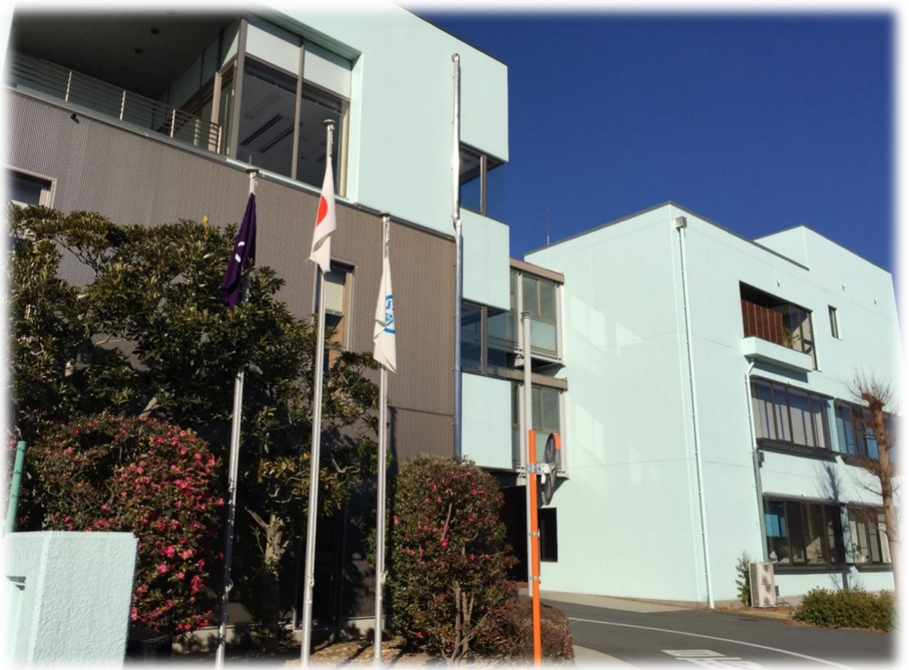
茨城県南水道企業団事務所棟
