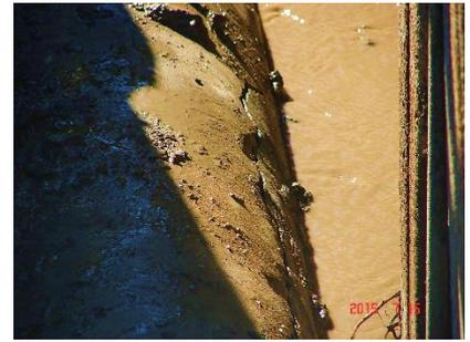
経年劣化により亀裂が生じた石綿セメント管
